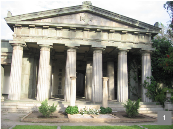
1. Mausoleo llamado comúnmente "Capilla Verde". Destaca por la cruz en sobrerrelieve en su cornisa.
