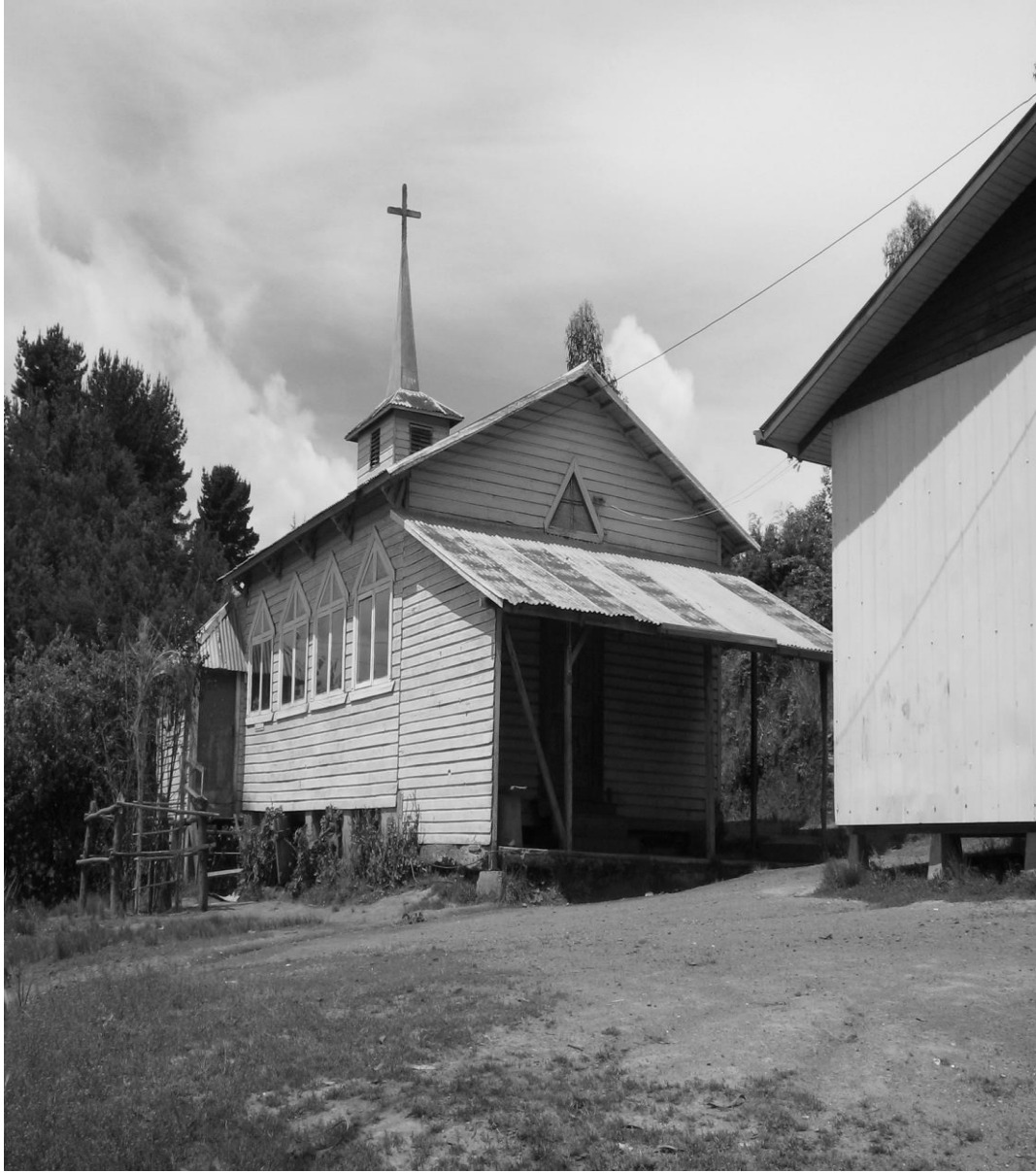
Iglesia Metodista localizada en la comunidad Tránsito Cea.
