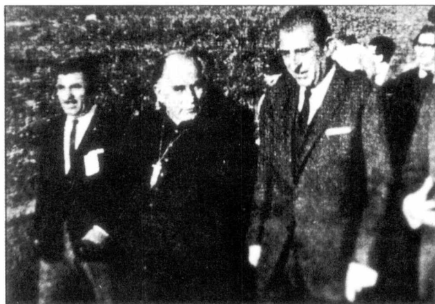
El cardenal Silva Henríquez y el Presidente Frei recorren las instalaciones de la estación terrestre de Longovilo, recién terminada.
