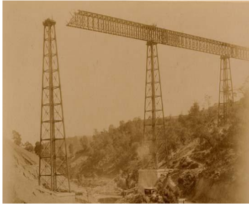
Figura N°7 Viaducto del Malleco
