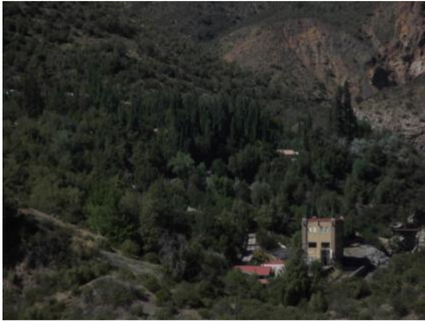
Figura 16: Central Hidroeléctrica Los Queltehues
