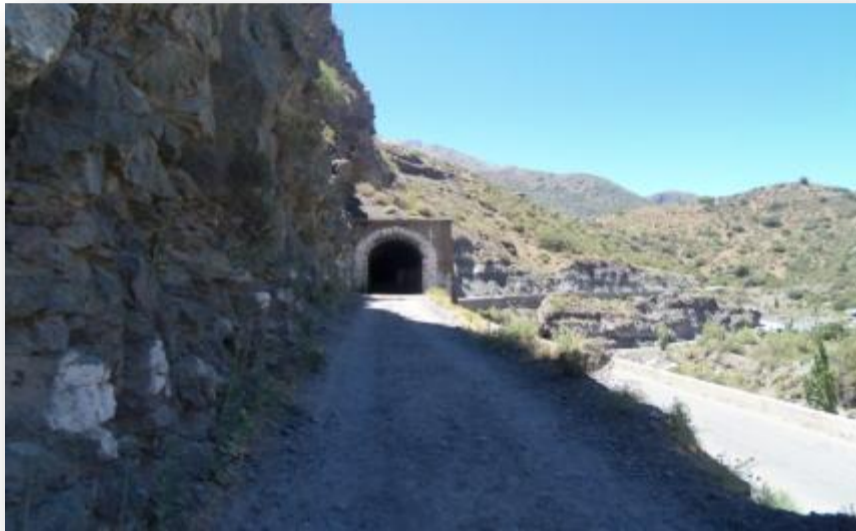
Figura 8: Túnel El Tinoco, después del levantamiento de la vía férrea
