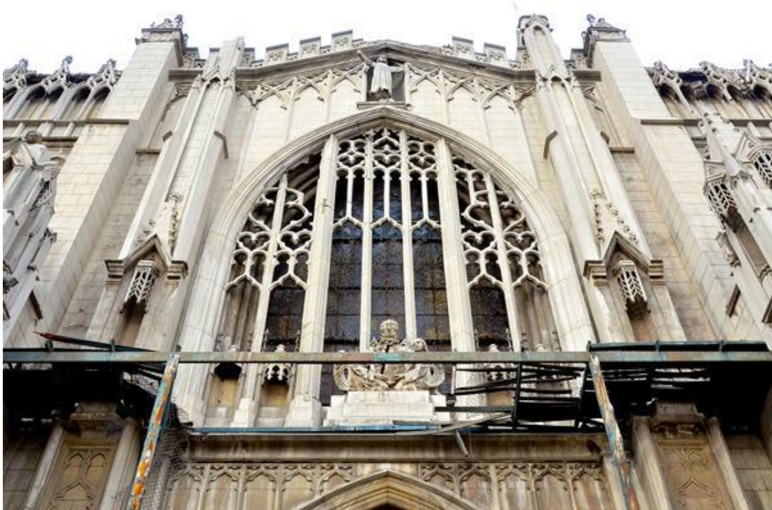
Ilustración 3 Lóbulos de la fachada
