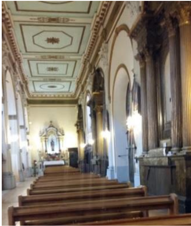
Ilustración 4 cielo de naves laterales, rosetón al centro.
