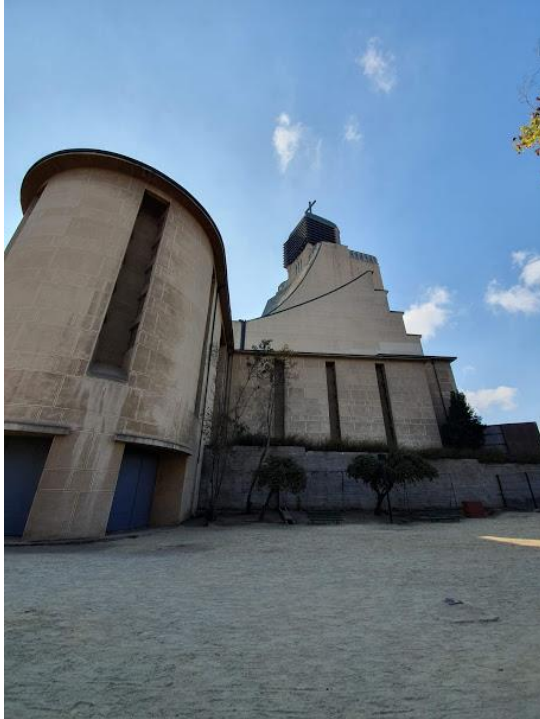
Ilustración 5a costado de la estructura de la basílica.
