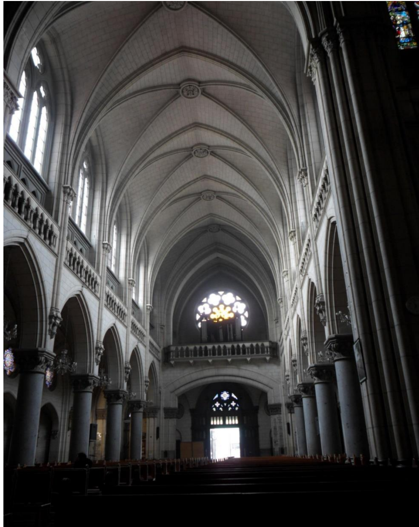
Ilustración 2 Ilustración 2 Arcos ojivales, propios de la arquitectura Gótica.
