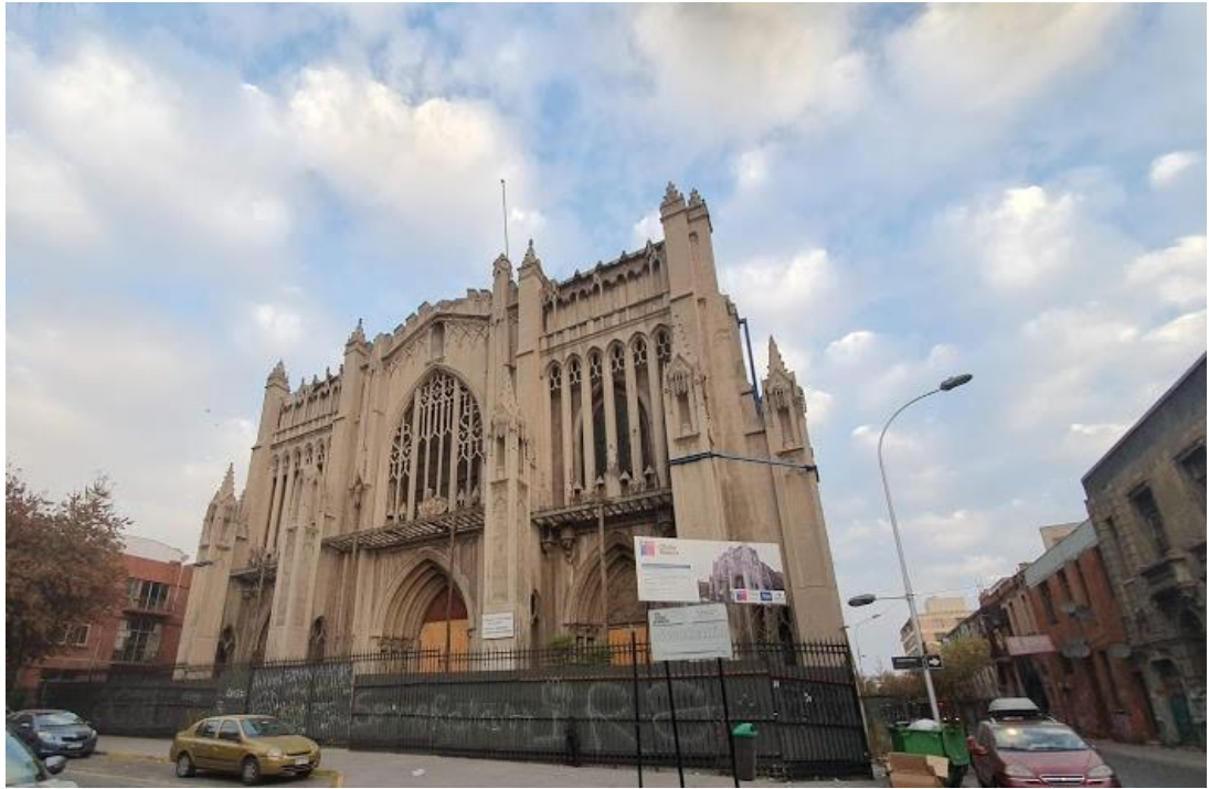
Ilustración 1 Fachada de Basílica del Salvador
