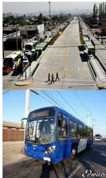
Figura 14.- Tarjeta 12, Conservación de Vías Transantiago
