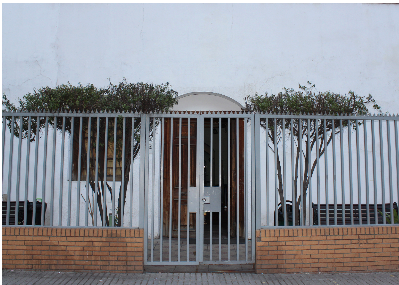
Fachada Casona Carmen 340 en 2024
