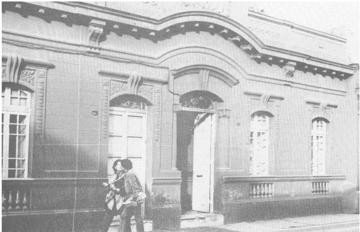
Fachada Casona Carmen 340.
